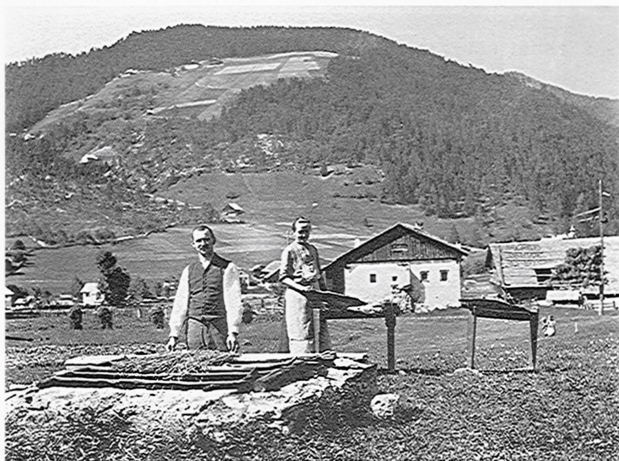
Fig. 34 - Forno per seccare la fibra di lino «forno da lin». San Vigilio di Marebbe (Alto Adige). Da: SCHEUERMEIER 1956.
